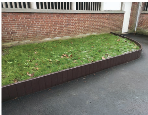
Retenue de terre
