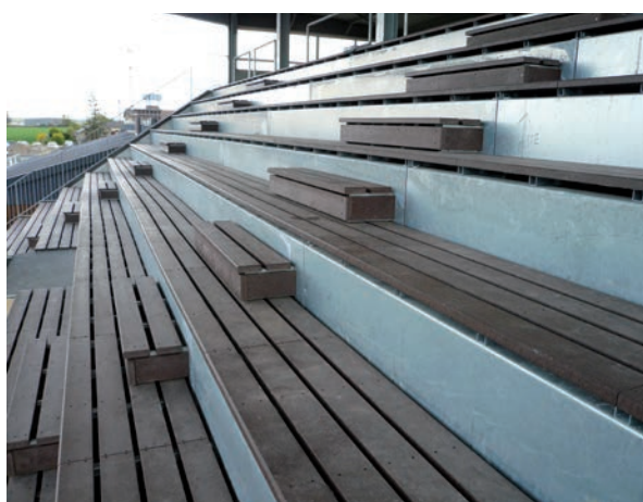
Rénovation de gradins
