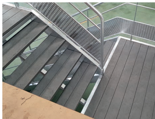
Coursive et escalier
