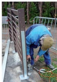
En option : fixation sur platine (Réf. 17.PLA) et goujons d'ancrage sur dalle béton existante **avec barre de renfort non apparente** remontant sur 1 m à l'intérieur du poteau
